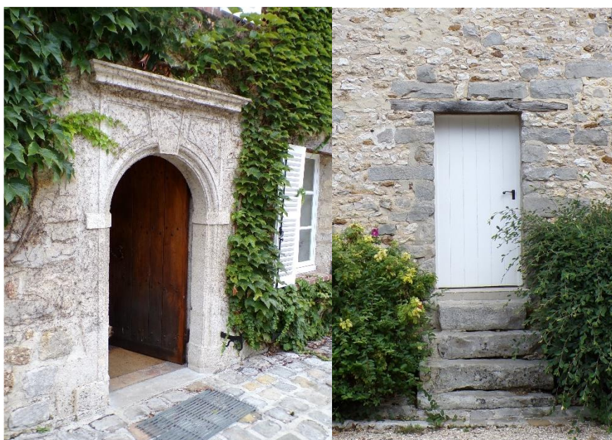
Figure 119 : Porte style gothique sculptée sur calcaire et porte plus traditionnelle avec encadrement en pierre de grès ©PNRGF
