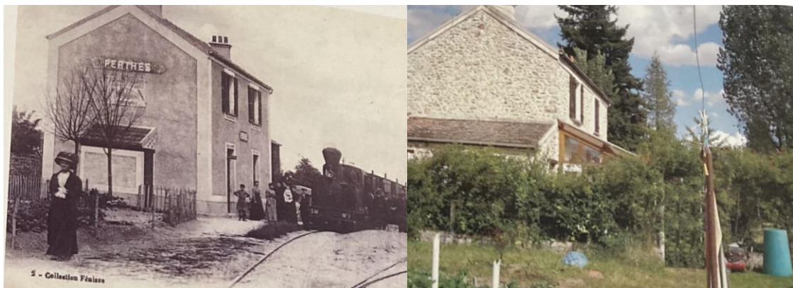
Figure 100 : Avant/après gare de Perthes-en-Gâtinais
