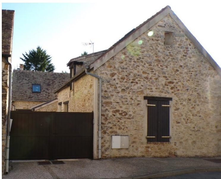
Figure 116 : Toit à deux versants pignon à découvert
