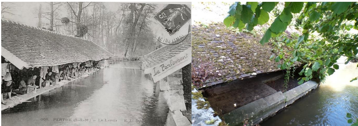
Figure 89 : Avant/Après Lavoir de La Planche
