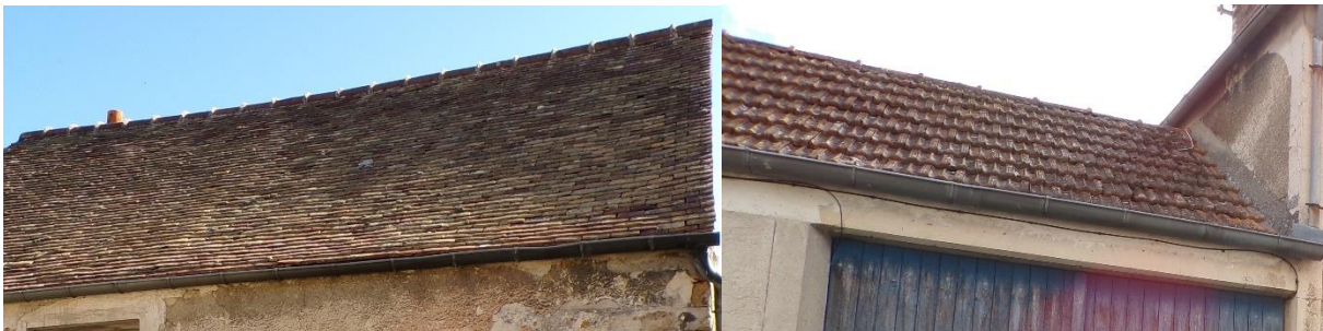
Figure 115 : Toit en tuiles plates anciennes et toits en tuiles plates mécaniques
