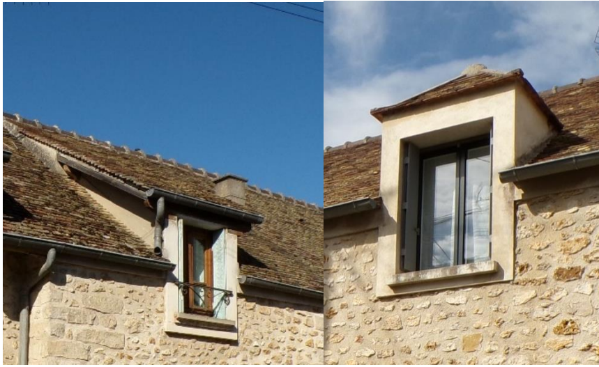
Figure 118 : Lucarne rampante et lucarne capucine ©PNRGF
