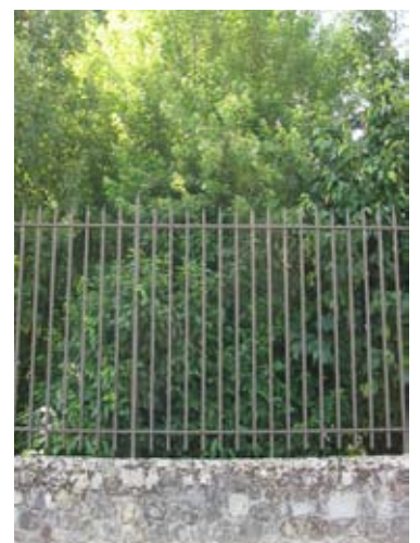
Mur bahut soutenant une clôture en ferronnerie
