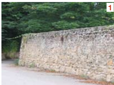
Clôture en maçonnerie
